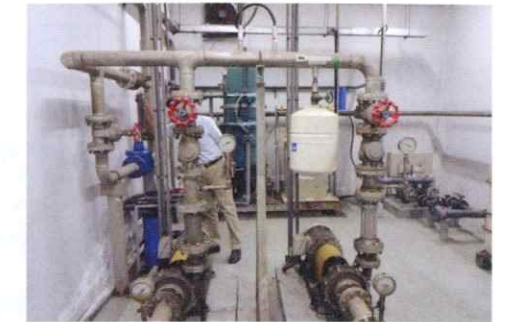
排水診断の様子
