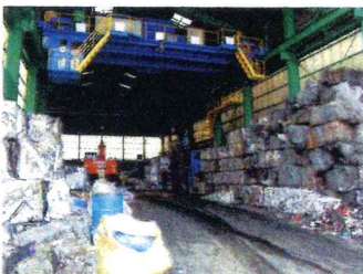
非鉄金属工場 広島県廿日市市木材港北3-73
