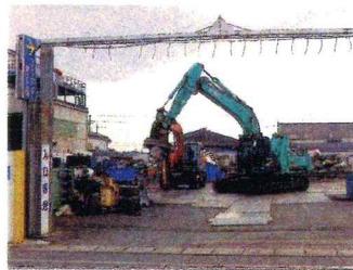
リサイクルセンター第2工場 広島県廿日市市木材港北6-12
