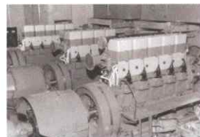
電源・予備電源用大型ディーゼルエンジン
