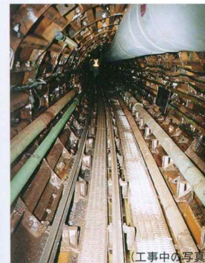
(工事中の写真) 関門海峡を横断するシー ルドトンネル(約3,600メ ートル)
