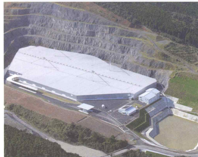
公共関与による産業廃棄物管理型最終処分場 エコパークエコパークかごしま H24～H26年度 エコパークエコパークかごしま(仮称)整備工事に関する施工関係評価業務 ＜公益財団法人 鹿児島県環境整備公社＞
