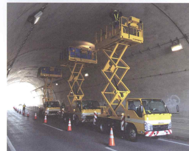
城南ずい道(詳細調査、補修設計)
