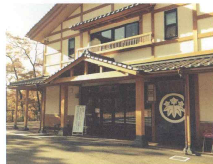
王湯会館(長野原町公衆浴場) (実施設計・監理) <群馬県長野原町>
