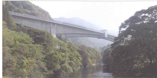
八幡平橋 <東日本高速道路株式会社> PC3径間有ヒンジラーメン箱桁橋 耐震性の向上・維持管理の軽減を目的とした、中央ヒンジ部の連続化と耐震補強設計。
