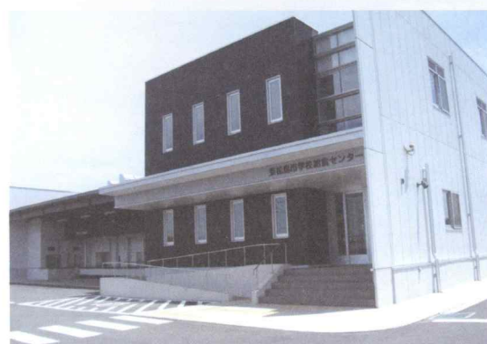
東松島市新学校給食センター 整備運営事業(PFI事業) <姉妹松山スクールランチサービス(SPC)>
