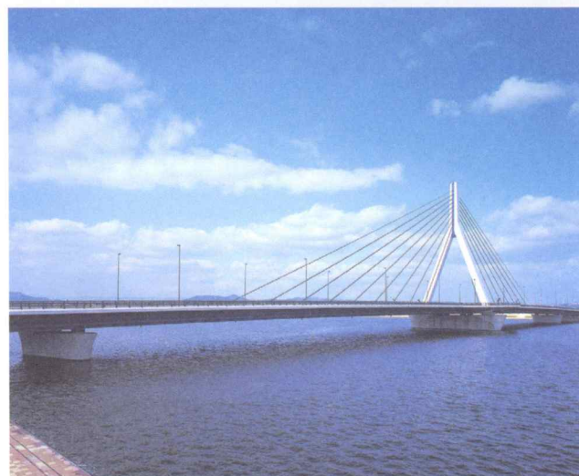
芦田川橋(詳細設計) <広島県>
