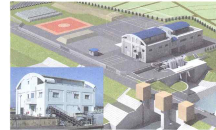
大淀川 瓜生野排水機場・防災ステーション <宮崎河川国道事務所>
