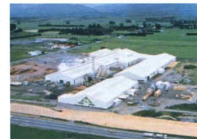
■ニュージーランド ワイララバ工場
