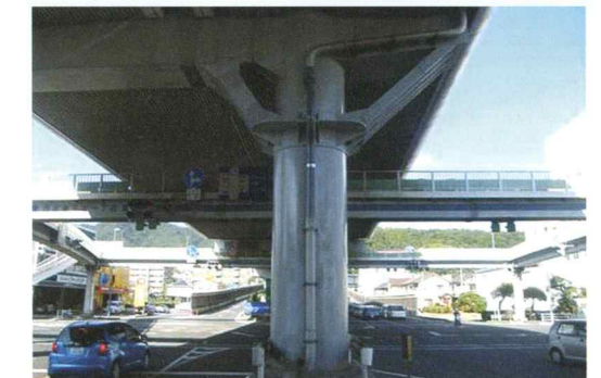
■国道2号線落橋防止工事 広島市西区己斐本町
