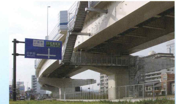
■広島高速3号線非常階段設備 広島市南区宇品海岸
