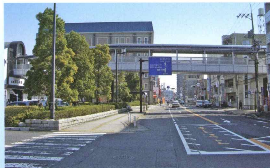
■広島電鉄五日市駅連絡橋 広島市佐伯区五日市駅前 街並みの美観向上にも考慮し、橋脚には落書き防止塗料が塗ってあります。
