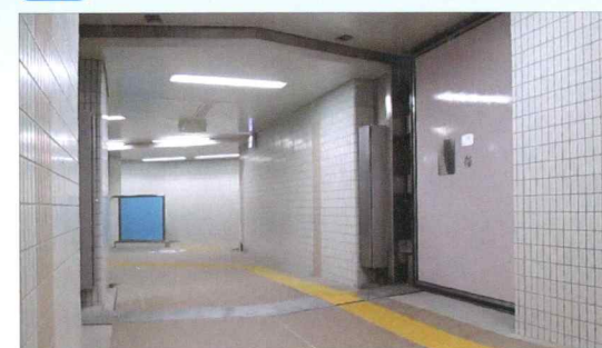
■大阪市営地下鉄 3号線本町駅23号出入口 鋼製(ステンレス製桁カバー付) W:3.0m、H:2.35m
