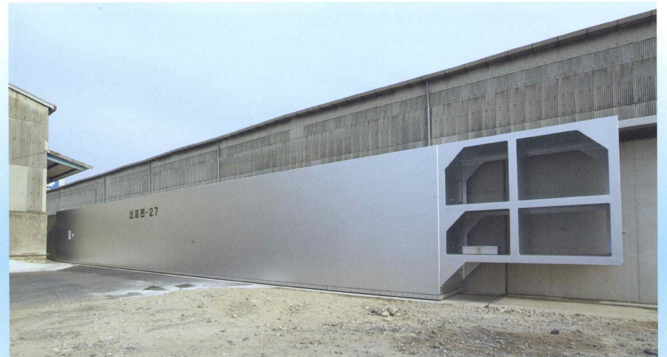
横引式ゲート(防潮扉) 広島市南区出島 アルミ合金製 W18.0m×H2.4m
