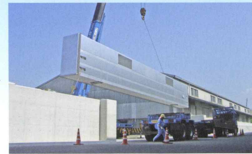
横引式ゲート(防潮扉) 広島市南区出島 アルミ合金製 W18.0m×H2.4m
