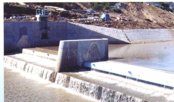
倒伏時 ■羽場崎井堰 (芦田川) 2連式鋼製自動倒伏堰(背面油圧シリンダー方式) W:36.8m, H:1.7m
