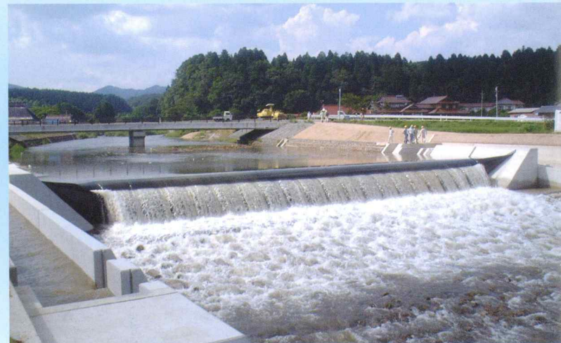
■江の川ラバーダム 広島県山県郡北広島町大朝 W:30.0m, H:2.2m
