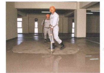
セルフベリング材施工
