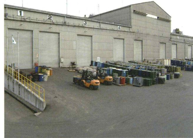
■廃棄物屋内貯留ピット棟
