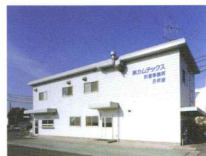
■計量事務所・分析室
