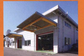
平成26年(2014) サービス研修棟完成
