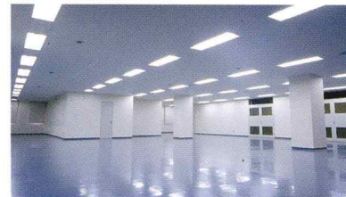
サーバ設置フロア
