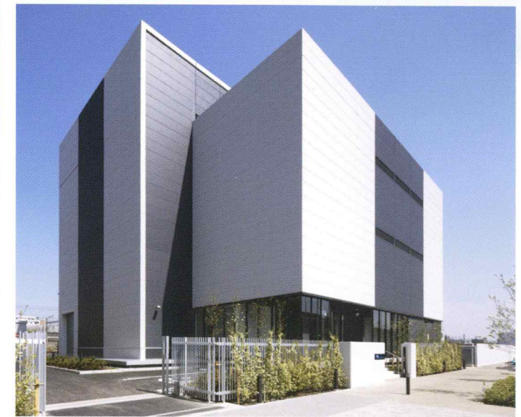
第2データセンター
