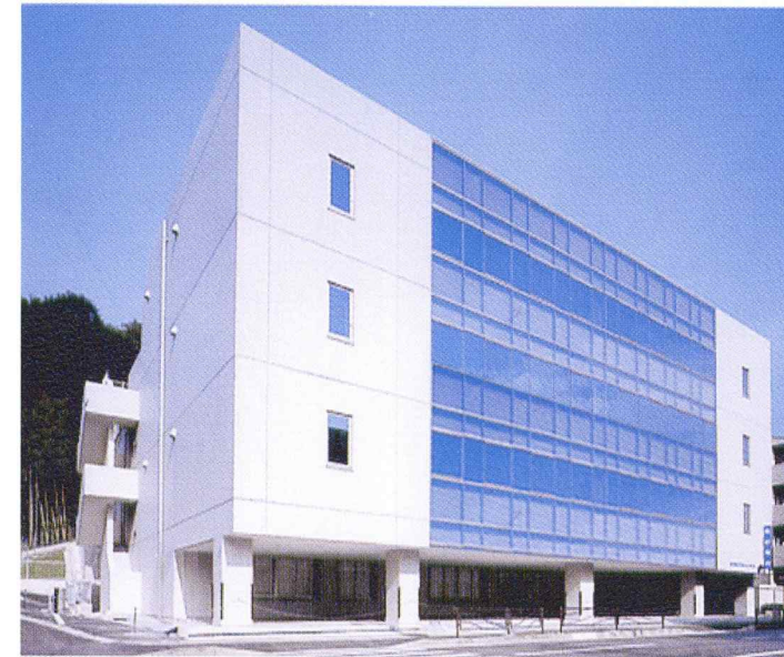
第1データセンター
