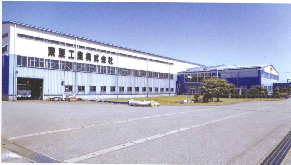
パイプ・プレファブ新潟工場全景
