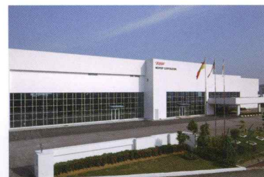
メディトップコーポレーション第2工場 (マレーシア) MEDITOP CORPORATION (M) SDN. BHD. Plant-2
