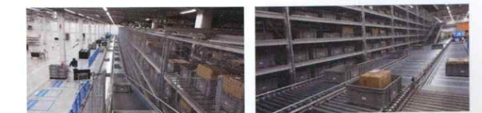
東京エレクトロン宮城 JIT 供給センター (自動倉庫)
