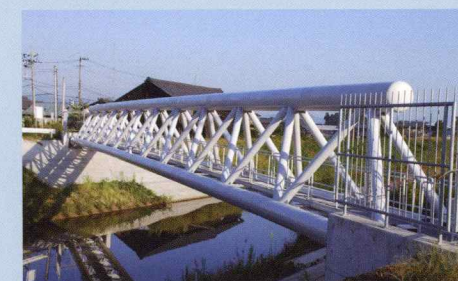
[ 施 主 ] 鯖江市都市 整備部上水道課 [ 形 式 ] 三角トラス形式 [ 仕 様 ] 口径 500A 支間長 47m CCP セラコート
