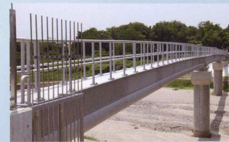
[ 施 主 ] 三重県企業庁北勢水道事務所 [ 形 式 ] π型補剛形式 [ 仕 様 ] 支間長 32m×3径間 +パイプビーム部 23mSUS
