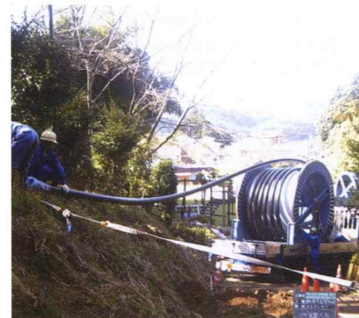
【山岳斜面への長尺配管】
