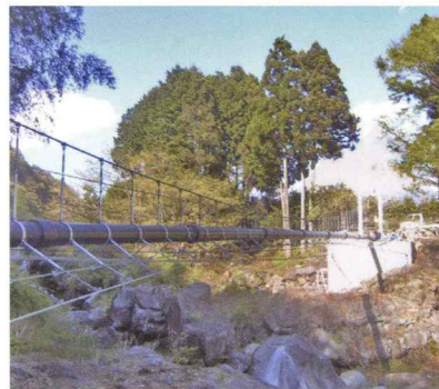
【吊橋式水管橋】
