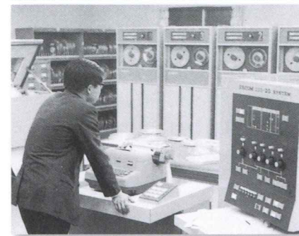
創業間もない頃のコンピュータ室FACOM230-20システム
