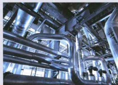
機械設備研修
