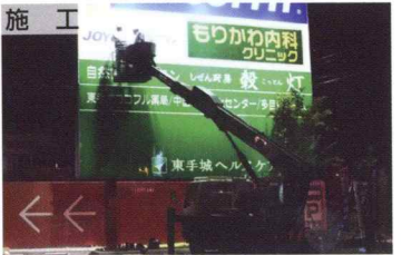
高所作業車や運搬車を持っており、専門スタッフが施工を行っていますので安心です。
