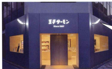
東京銀座/店舗入口内照式サイン
