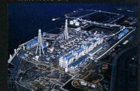
10 碧南火力発電所(愛知県碧南市)
