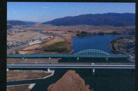
5径間連続箱桁橋
