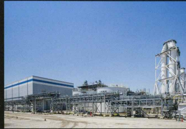
7 西名古屋火力発電所(愛知県海部郡)
