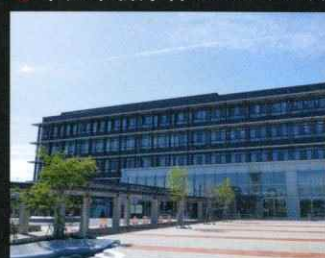
4 半田市新庁舎(愛知県半田市)
