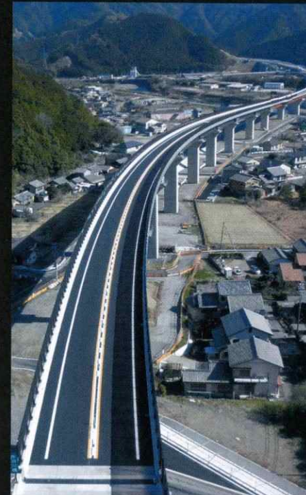
6径間連続少数版桁橋 他1橋
