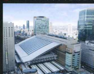
5 ノースゲートビルディング(大阪府大阪市)
