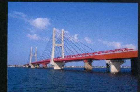
4径間連続斜張橋
