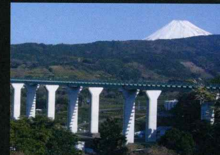
13径間連続少数版桁橋 他1橋
