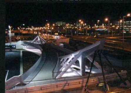
フィンバックトラス橋
