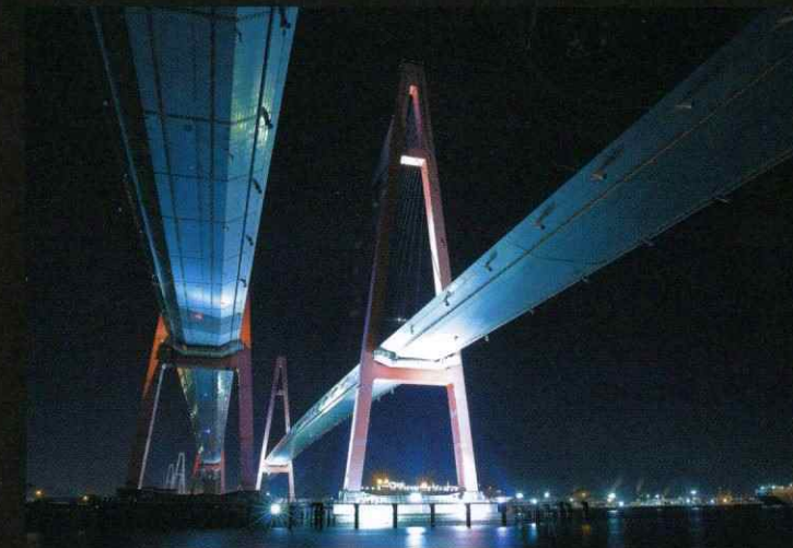
斜張橋 / 斜張橋の耐震補強
