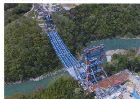
ケーブルエレクション斜吊り工法
