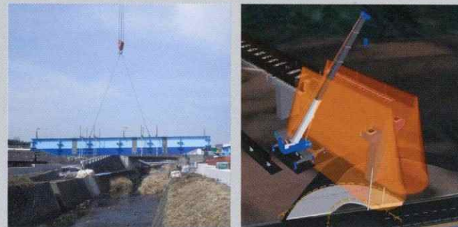
●TMブリッジ 災害復旧時のインフラ整備に不可欠な重仮材「TMブリッジ」、少主術化で施工性・経済性に優れています。 ●CIM (Construction Information Modeling) 施工計画で架設時における市道規制についてCIMを活用した事例。
