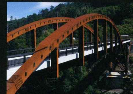
バランスドアーチ橋
