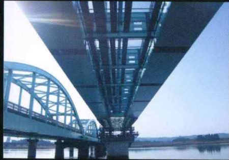
5径間連続箱桁橋
