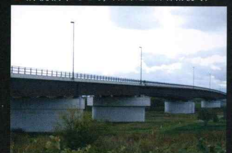
3径間連続鋼床版箱桁橋
