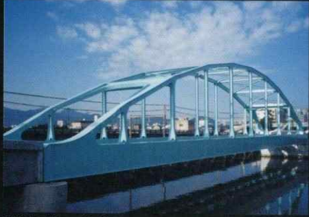
開床式下路ランガー桁橋
