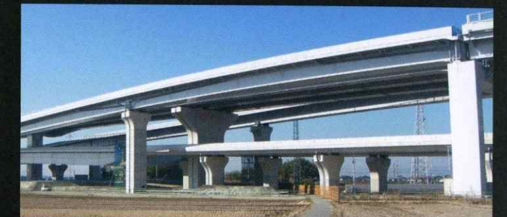
2径間連続鋼床版箱桁橋 他3橋
