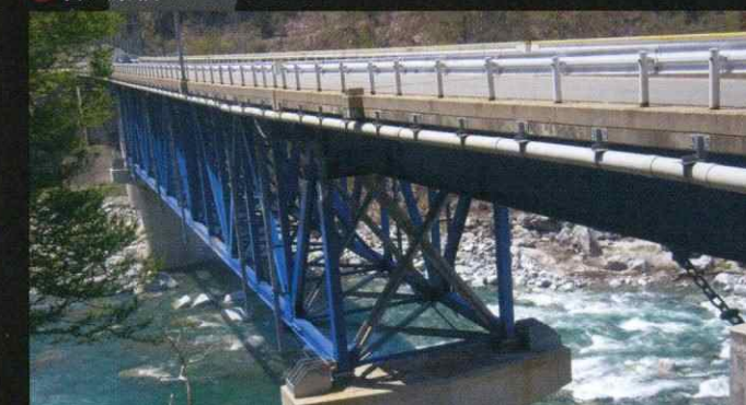
トラス橋 / トラス補修工 (座屈拘束ブレース設置工)
