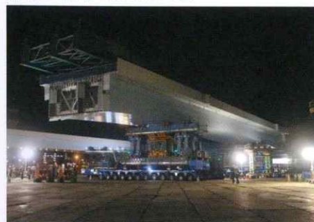
多軸台車を利用した一括架設工法
