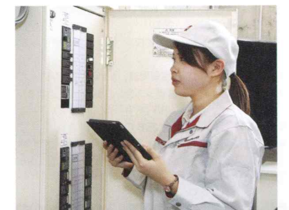
建築設備の日常点検
