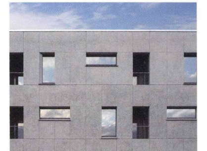
社員で施工した自社独自製のコンクリート打放し外壁
