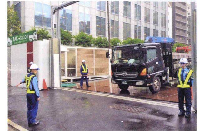
待機を終え「TAK-station」から出る搬入車両
