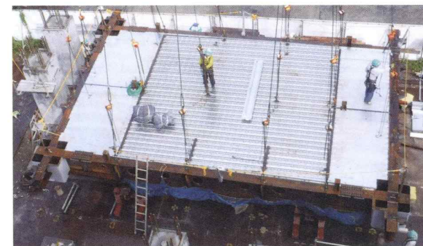
柱梁取合い含む一体ユニットの地組み
