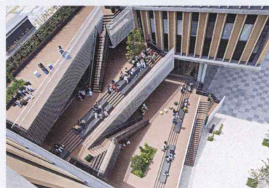
「ステップテラス」は学生の動線となるとともに、外部の緑や富士山への眺望による憩いの場所であり、建物内への通風も確保しています。
