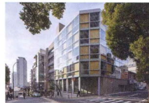
兵庫県林業会館
