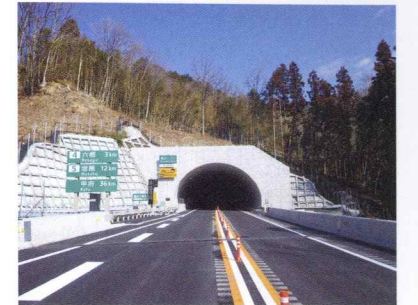
中部横断道 城山トンネル工事
