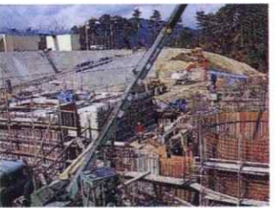
城山浄水場整備工事(昭和56年)
