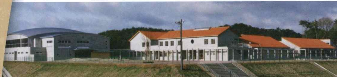
三和町立三和中学校(平成12年)
