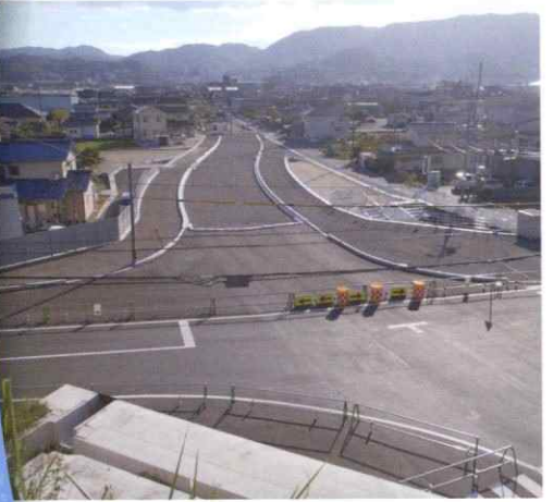
本山鶴岡線道路改良工事(平成24年)
