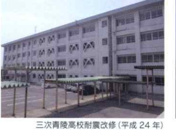
三次青陵高校耐震改修(平成24年)
