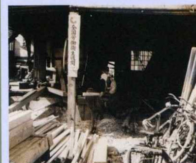
新設された木工場
