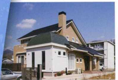
A棟新築工事(平成22年)
