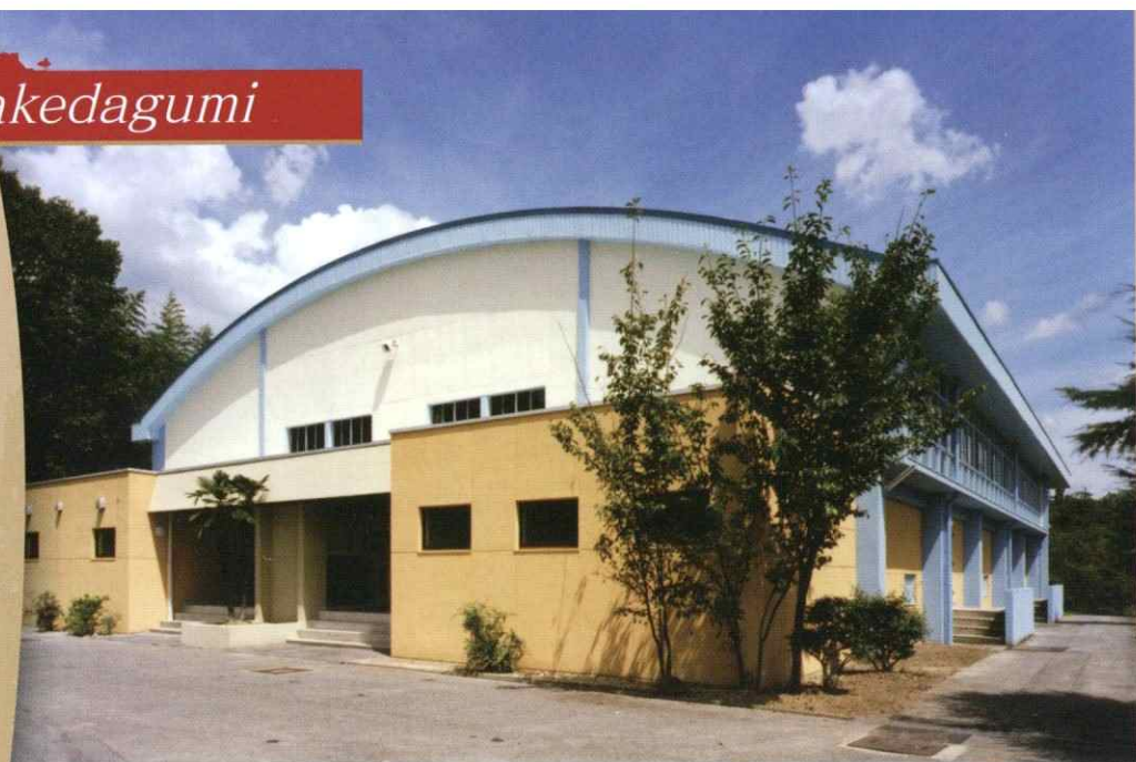
御調中学校屋内運動場リフレッシュ工事(平成15年)
