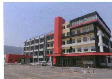
府中市庁舎耐震改修(平成26年)
