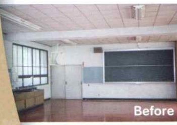
教室リフレッシュ工事(平成16年)
