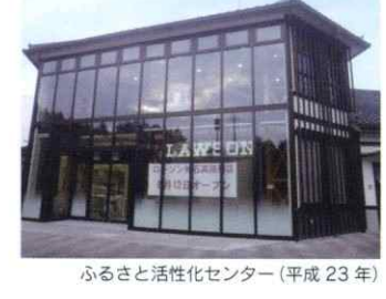
ふるさと活性化センター(平成23年)
