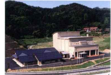
高蓋総合センター新築工事(平成13年)
