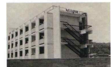
県営11被服年金住宅(昭和39年)
