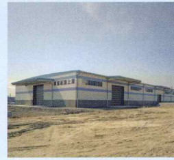
岩国港荷さばき施設上屋
