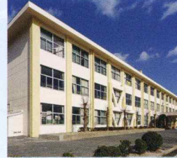
平田中学校耐震補強工事
