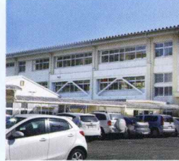
美和中学校耐震補強工事
