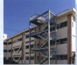
岩国小学校耐震補強工事
