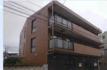
シャトー江北マンション新築工事 (足立区)
