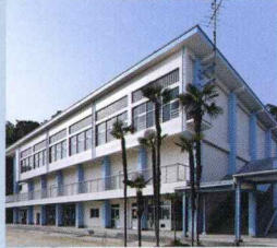
由宇小学校(講堂)耐震改修工事
