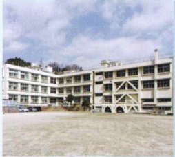
装港小学校耐震補強工事
