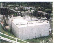
汚水処理施設
