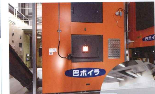
上: バイオマスボイラーでは、CO 2 を吸収して育った木を燃料としているので大気中の炭素量は増加しない 右: 電力やバイオマスボイラーの運用をマネジメントシステムによって効率的に管理
