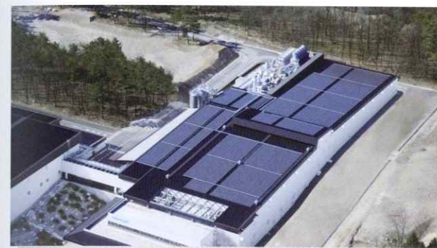
左:「サントリー天然水 南アルプス白州工場」には飲料業界最大規模(2021年1月時点)となる490kWの太陽光発電パネルを設置 右: サントリーホールなどの文化施設も再エネ由来電力に切り替え
