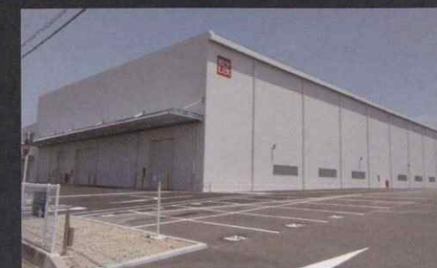
(株)キーレックス防府工場 HOTプレス棟 外部
