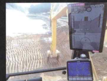
ICT建設機械による施工
