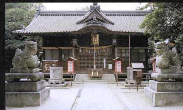
宇津神社本殿及び拝殿(修復工事)
