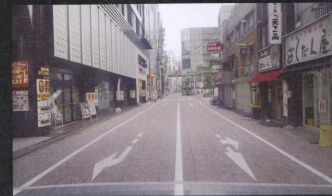
中1区203号線(舗装改良)
