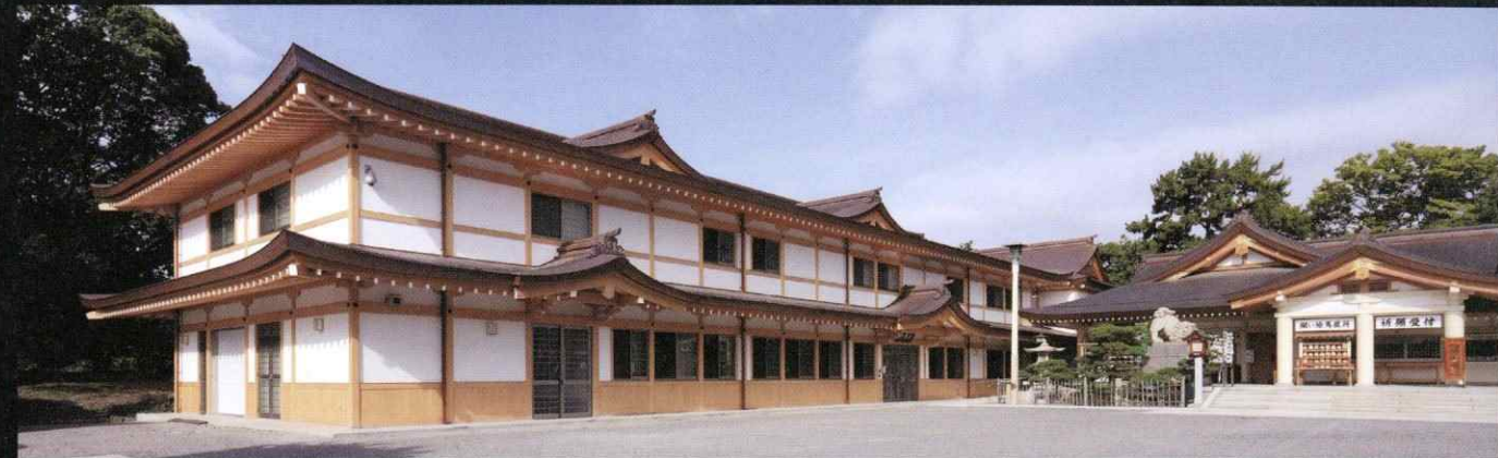
広島護国神社事務所・直会殿(改築)
