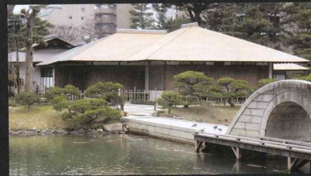
縮景園清風館(屋根葺替・名勝)
