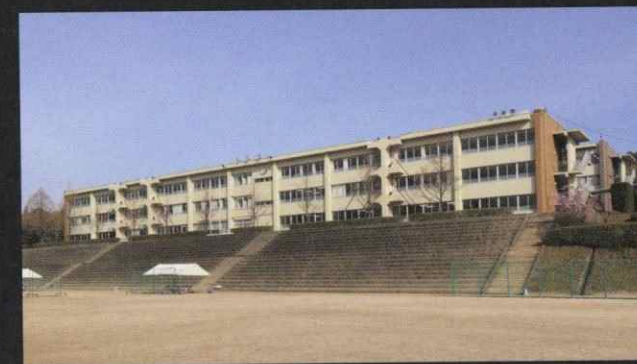
広陵学園広陵高等学校本館(外壁改修)
