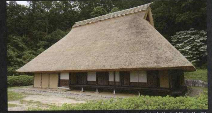
重要文化財 播山家住宅(保存修理)
