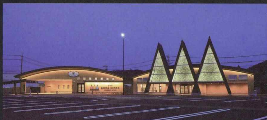
道の駅 三矢の里あきたかた 休憩情報発信棟・レストラン棟
