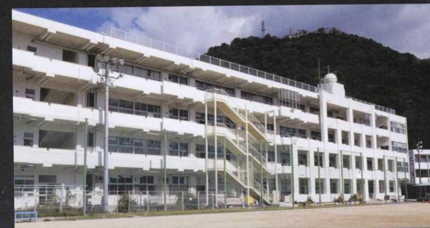
広島市立楠那小学校(耐震改修)
