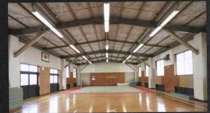
安佐北警察署武道場(耐震改修)
