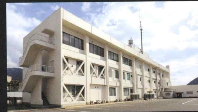
安佐北警察署庁舎(耐震改修)
