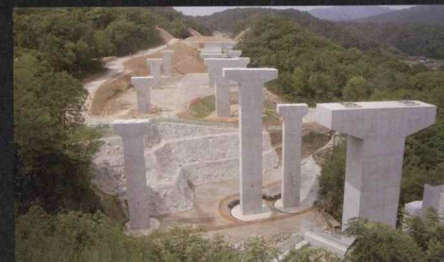
安芸バイパス清谷高架橋第5下部
