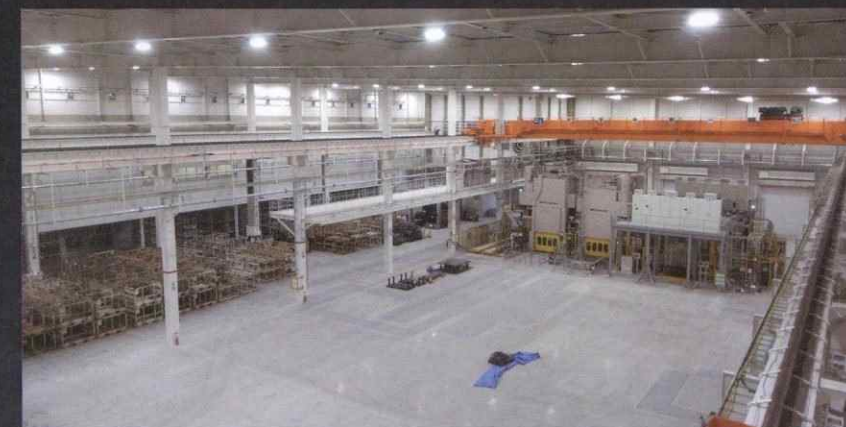
(株)キーレックス防府工場 HOTプレス棟 内部
