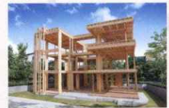
国内初木質梁勝ちラーメン構法
