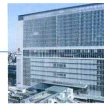
横浜支社 新横浜中央ビル15F
