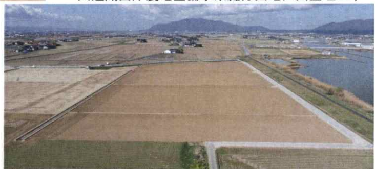
宍道湖西岸農地整備事業灘分団地区画整理工事
