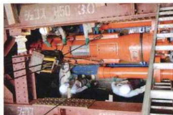
川西污水幹線築造工事 (第26工区)
