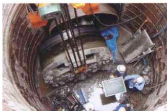
下補第16号 池田雨水幹線築造工事 (第1工区)
