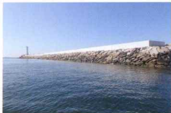
東防波堤災害復旧工事
