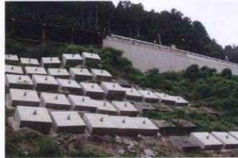
西条久万線 生活道路改良整備工事他
