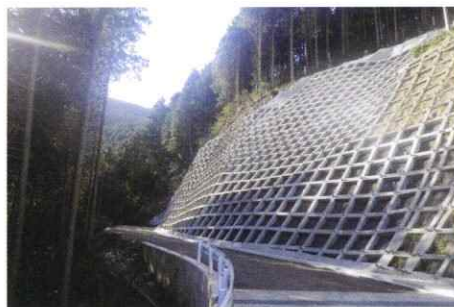
平成27年度 基幹(加)第1-1号 林道開設工事
