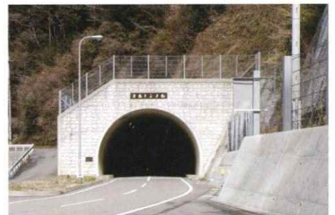
新居浜別子山線清滝トンネル
