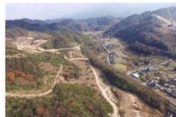
新居浜メガソーラー発電所
