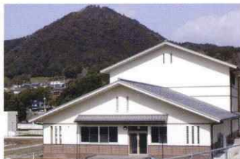
伊方町九町浄化センター
