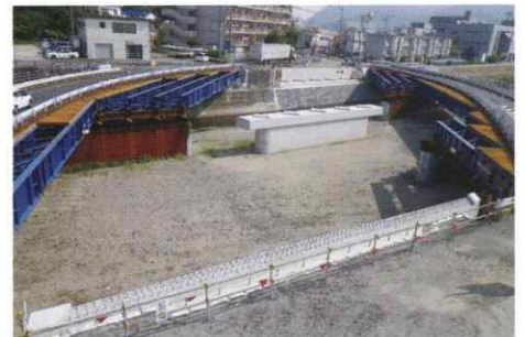
平成25-26年度 川之江橋下部工事
