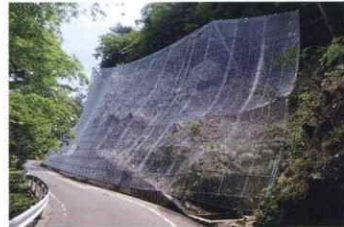
新道防減第25号の1(主)高知伊予三島線 道路防災・減災対策工事
