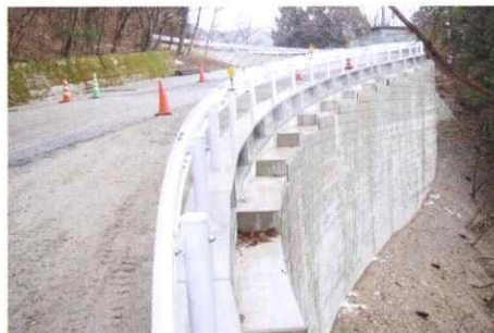
新居浜別子山線 道路改築工事
