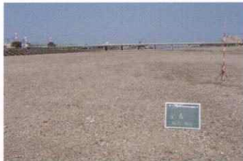
国改第1号の3(二)国領川水系国領川総合流域防災工事
