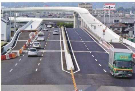
松山自動車道 松山インターチェンジ工事
