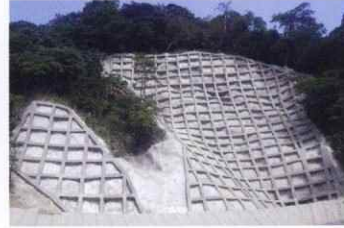
第3号 災害関連緊急治山工事
