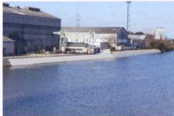
国領川水系 国領川 河川災害復旧工事
