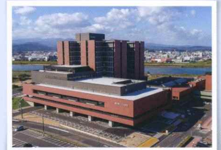
12 鳥取県立中央病院 新築 保健 医療施設
