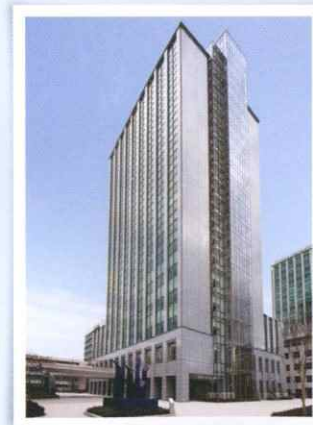
8 千葉工業大学 津田沼キャンパス1号館 新築 保健 教育施設
