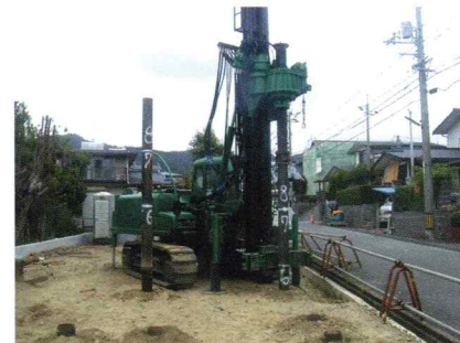
ガイアパイル施工
