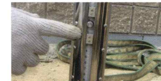
スライドウェイトによる支持力確認
