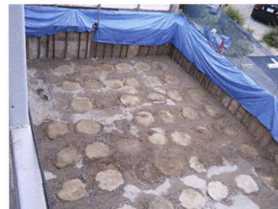
掘削後出来形
