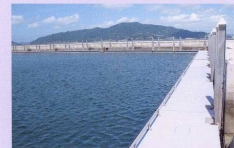
FRP製浮浅橋総延長 約465m (42函)
