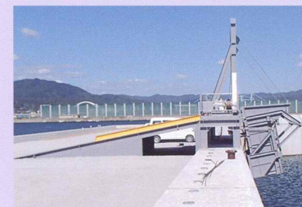
ダンピングシュート W11.3m×L18.3×H8.0m
