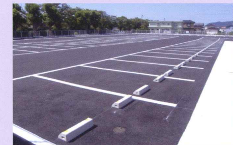
下松市体育館駐車場整備
