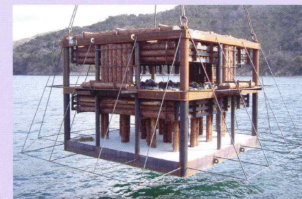
鋼製魚礁「シーファーム」間伐材ハイブリッド型
