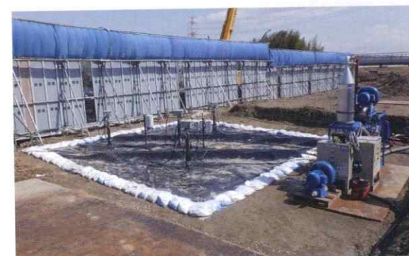
VOC(揮発性有機化合物)対策としての熱脱着土壌浄化(試験施工)(三重県桑名市)
