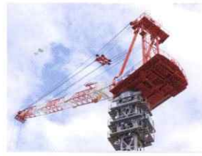
主力の大型タワークレーン
