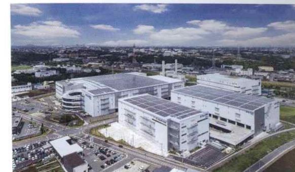
S・LOGI新座 手前がEast2(埼玉県新座市)
