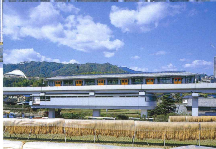
●広島新交通駅 アストラムライン
