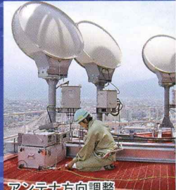
アンテナ方向調整
