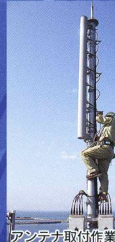
アンテナ取付作業
