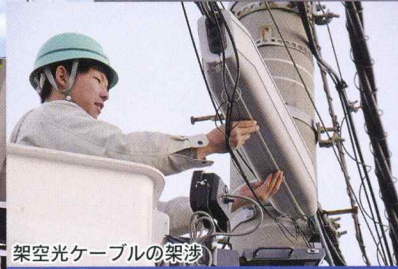
架空光ケーブルの架渉
