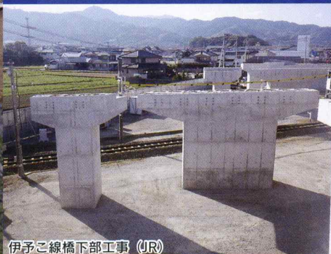
伊予線橋下部工事（JR）
