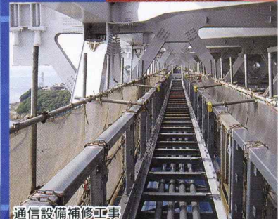
通信設備補修工事
