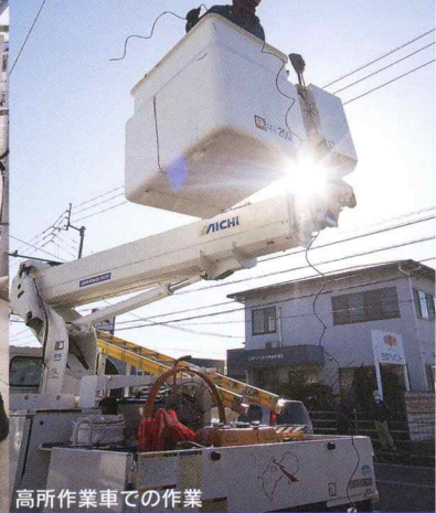
高所作業車での作業
