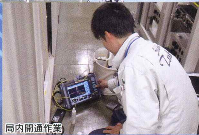
局内開通作業
