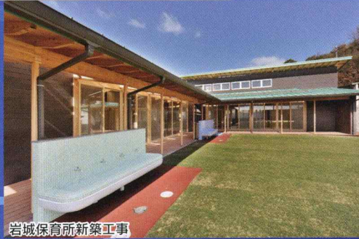
岩城保育所新築工事
