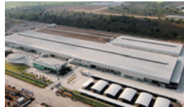
タイ住宅生産工場
