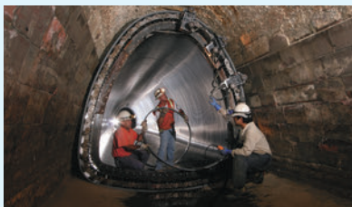
米国での管路更生工事の様様
