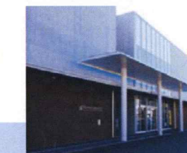
図書館 空調設備
