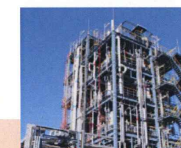
化学工場 電気・計装設備
