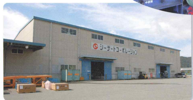
防府鋼材センター
