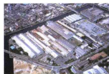
阪神支店 尼崎作業所 日鉄ステンレス鋼管(株)尼崎工場内 兵庫県尼崎市鶴町1番地
