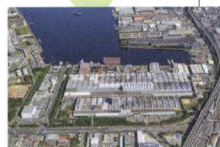
阪神支店 堺作業部 日鉄日新製鋼(株)堺製造所内 大阪府堺市西区石津西町5番地
