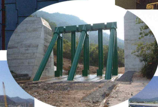
スリットダム (鋼製透過型堰堤)
