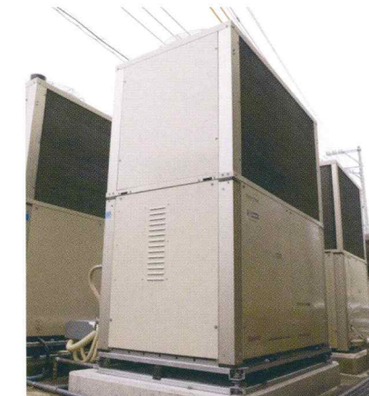
停電時対応型LPガス空調システム
