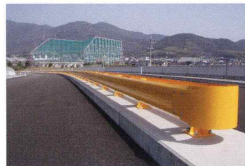
ガードレール
