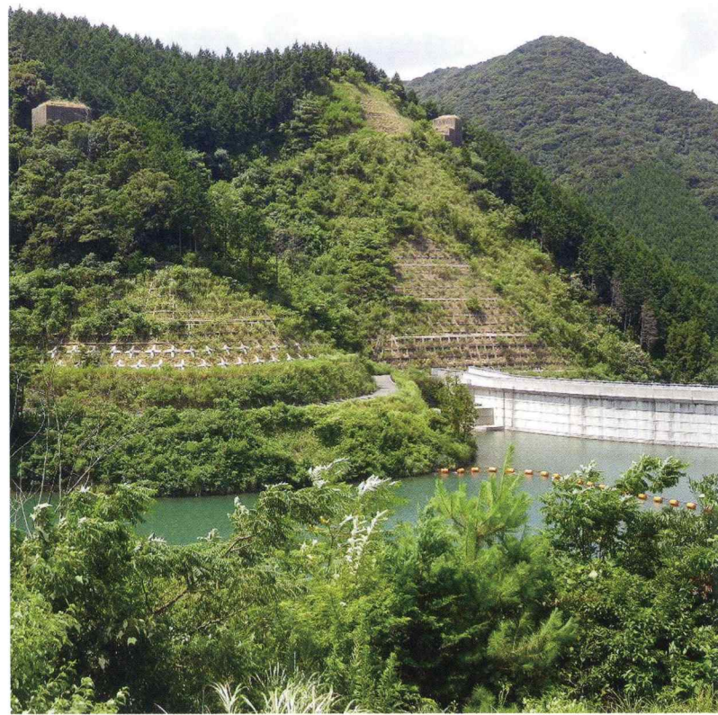
ダムサイト法面保護工
