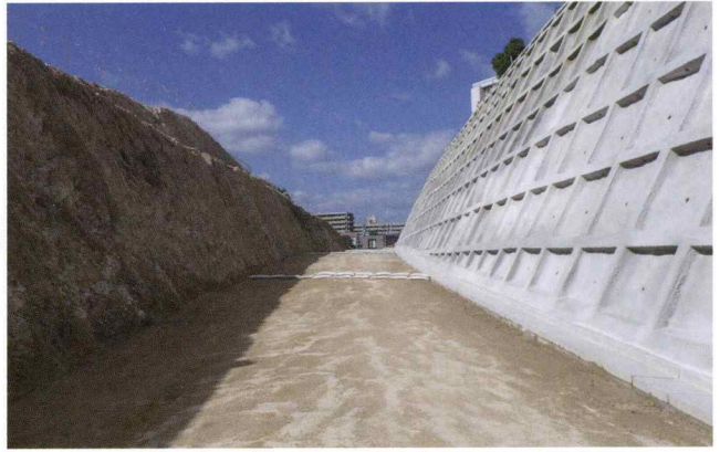
茂陰向洋駅線街路改良
