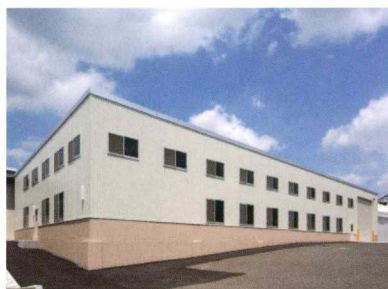
ハマガ八本松工場倉庫棟増築
