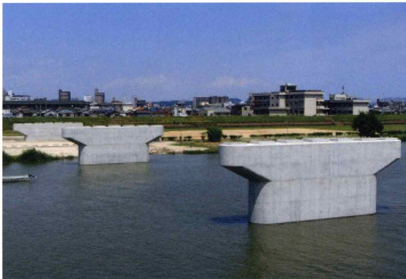
県道福山沼隈線道路改良(1工区)
