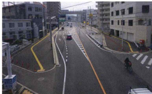
県道広島海田線交差点舗装
