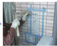
不良箇所の除去
