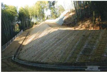
緑井地区進入路整備
