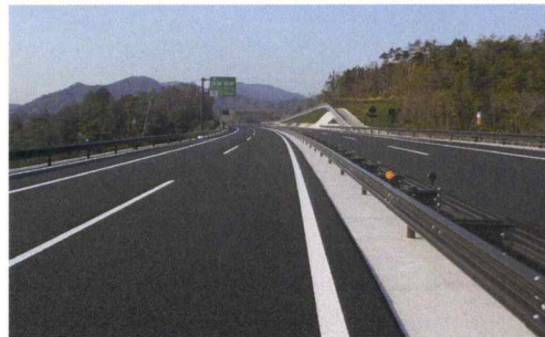
東広島・呉道路黒瀬地区安全施設
