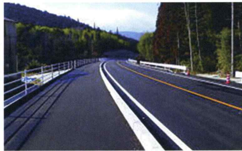
一般県道 内海三津線道路改良(舗装2工区)
