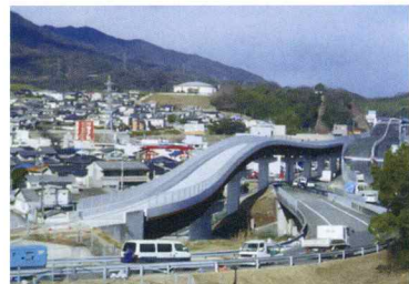
西広島バイパス宮内床版設置外
