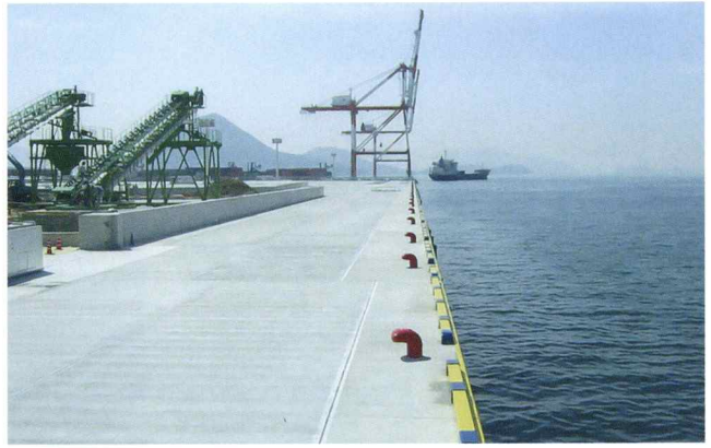
特定重要港湾 広島港 岸壁改良
