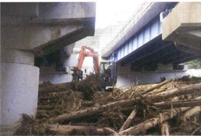
平成26年8月豪雨災害緊急復旧(緑井・八木)
