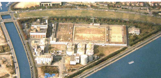
西部浄化センター建設
