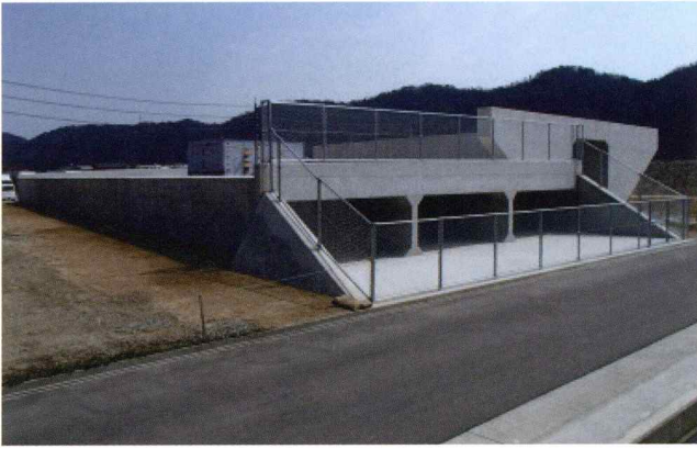
東広島高田道路改良(その1)
