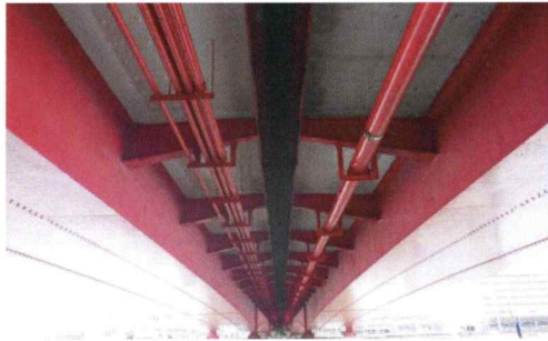
国道2号線黄金橋外橋梁補修
