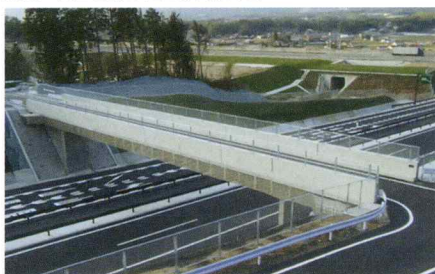
東広島・呉道路 1工区側道外改良
