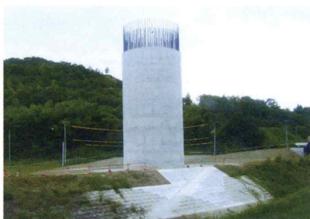
尾道・松江自動車道国兼川橋下部
