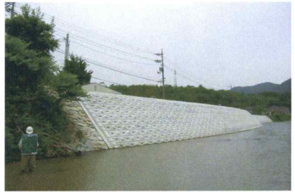
1級河川小瀬川水系玖島川 河川災害復旧
