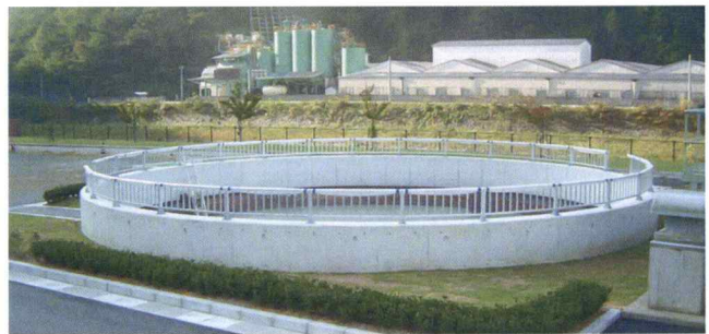
東城町東城浄化センター建設
