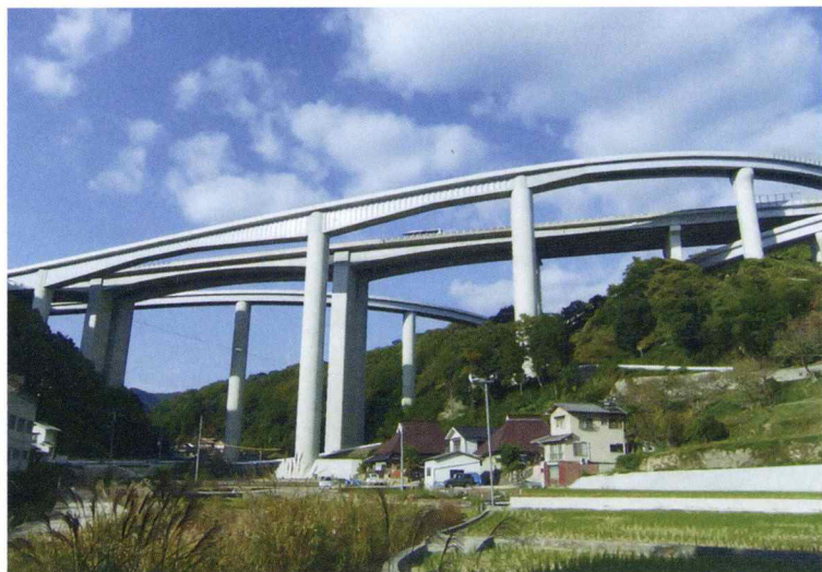
尾道自動車道 尾道ジャンクションBランプ橋下部
