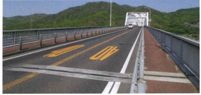
国道487号線(早瀬大橋)橋梁補修
