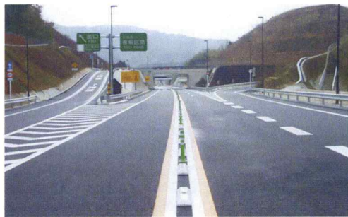
松江自動車道三刀屋木次IC舗装
