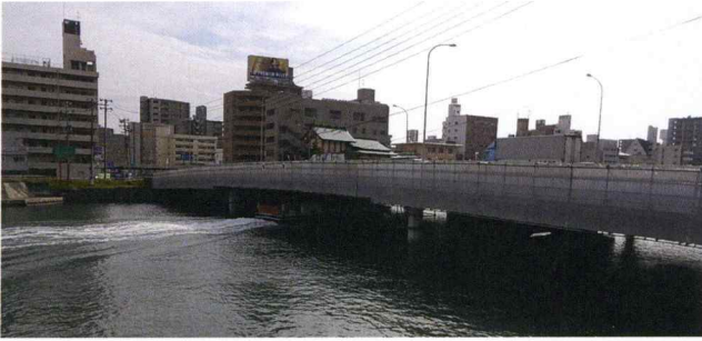
国道2号・54号細野橋外橋梁補修
