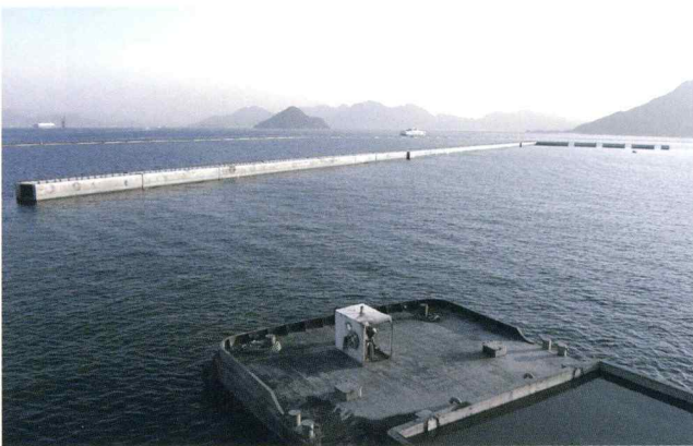
広島港湾環境整備(出島地区 17年度3工区)
