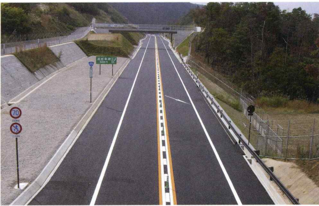
東広島・呉道路上三永IC外改良
