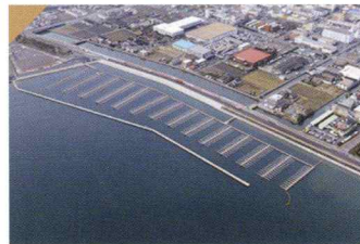
福山港 港湾修築工事 (一文字地区ポートパーク2工区)
