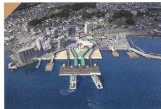
地方港湾厳島港(宮島港) みなとの賑わいづくり事業 浮棧橋据付工事
