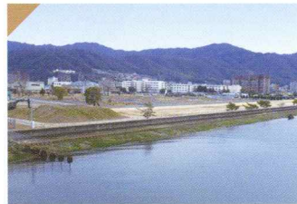
広島港海岸中央東地区(矢野) 護岸(改良)築造工事
