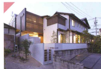
栗原町の家 増築工事
