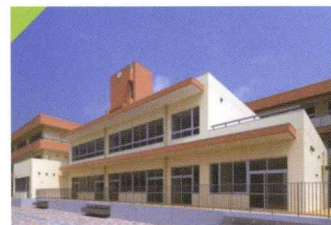
忠海地区小中一貫校 (忠海学園)新設工事
