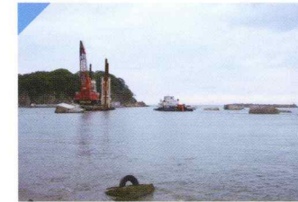
岩手県宮古市田老 (災害復旧工事)
