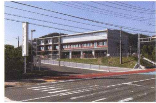
三原市消防(署)庁舎
