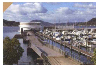
ペラピスタマリーナ 浮棧橋改修工事
