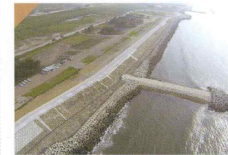
宮城県東松島市大曲 (災害復旧工事)
