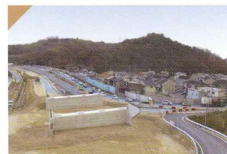
木原道路福地橋 下部工事
