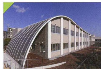
広島県立世羅高等学校 管理教室棟(1号棟)改築 その他工事
