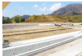
東広島・呉道路 黒瀬IC外改良工事
