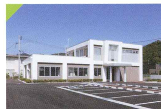
竹原簡裁庁舎 新営等工事
