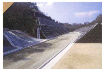
福山沼隈線 道路改良工事
