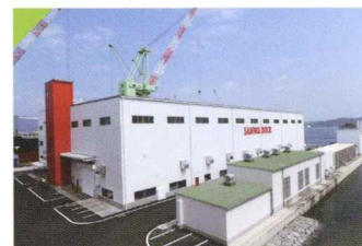
三和ドック東工場 新築工事
