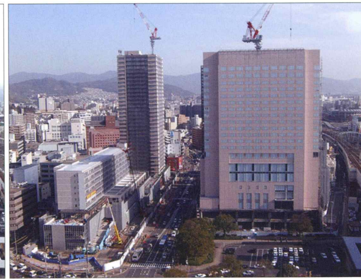
若草町地区第一種市街地再開発事業（鉄骨工事完了）
