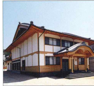
常泉寺 庫裏 外観南東面
