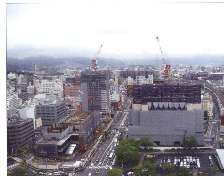
若草町地区第一種市街地再開発事業（鉄骨工事施工中）
