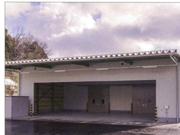
矢野運送 上下事務所・倉庫
