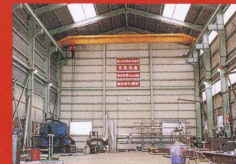
▲鉄骨加工工場
