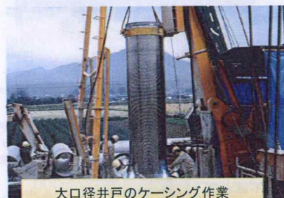
大口径井戸のケーシング作業
