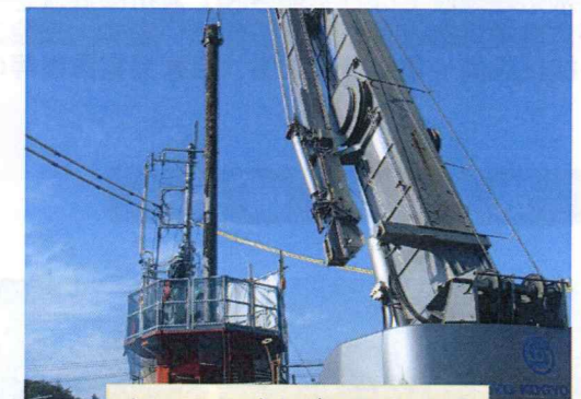
古いケーシングパイプの引き上げ作業
