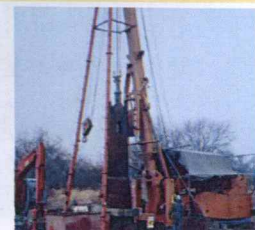
清水で掘削するプルバック工法
