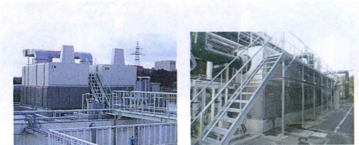
各種施設に導入されている横型薬液脱臭・排ガス処理装置
