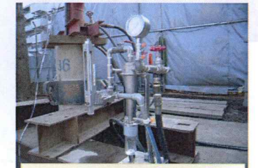
揚砂量測定作業
