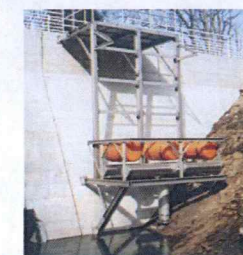
取水用フロート式スクリーン
