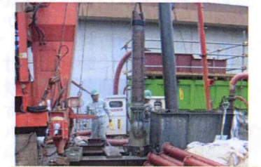
仕上げ作業：パーシャルサージング工法
