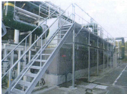
横型薬液洗浄装置
