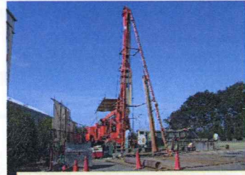
地層に衝撃を与えて掘削するパーカッション工法
