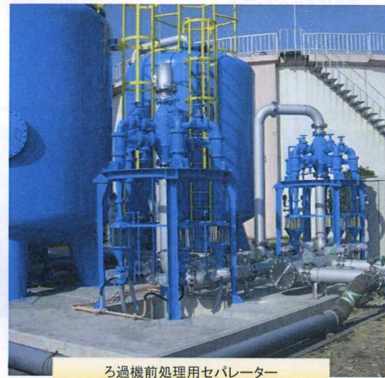
ろ過機前処理用セパレーター
