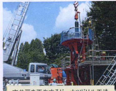
古井戸を再生するドーナツドリル工法
