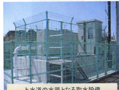
上水道の水源となる取水設備
