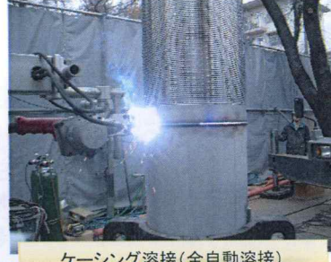
ケーシング溶接(全自動溶接)
