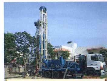
ロータリー工法によるさく井工事
