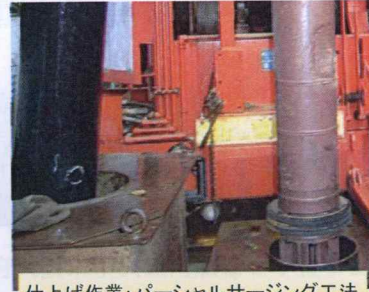
仕上げ作業：パーシャルサージング工法
