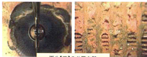
更生【前】の井戸内部
