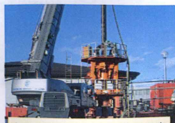
古井戸を再生するドーナツドリル工事
