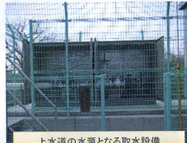
上水道の水源となる取水設備
