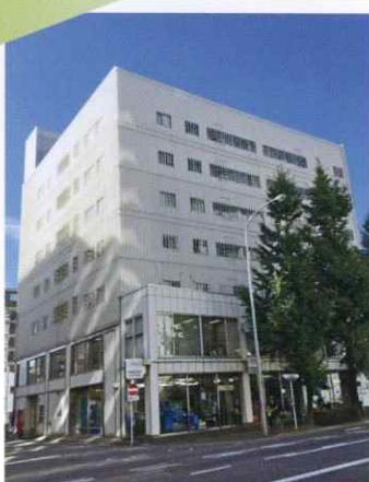
九州中央営業所 〒812-0016 福岡県福岡市博多区博多駅南3-16-28 三甲福岡ビル TEL:092-414-3535 FAX:092-411-6959
