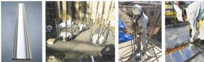
耐震スリット材 クラウンパイルアンカー パイルスタッド スタッドジベル
