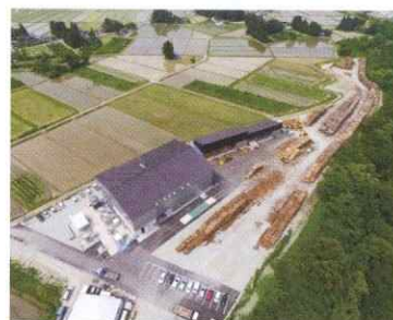
木質バイオマスガス化発電設備
