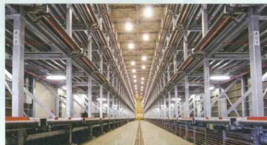
在日米空軍横田基地カーゴハンドリングシステム
