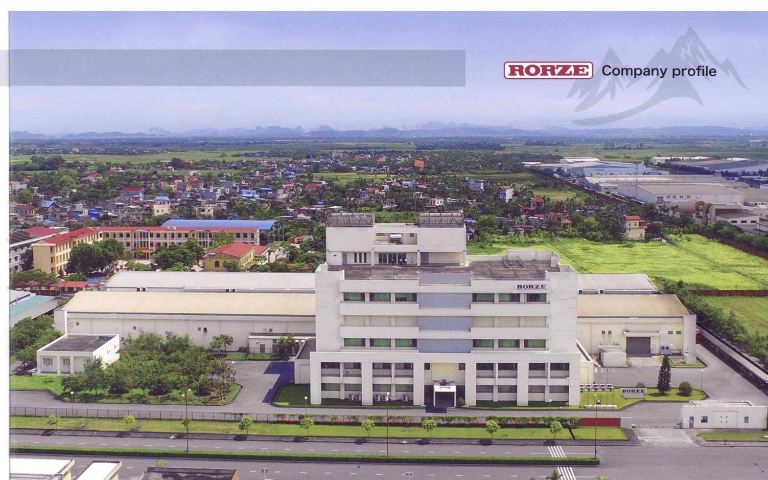
RORZE ROBOTECH CO., LTD. (ベトナム工場) RORZE ROBOTECH CO., LTD. (Vietnam factory)
