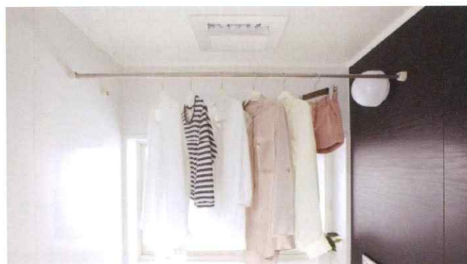
浴室暖房乾燥機
