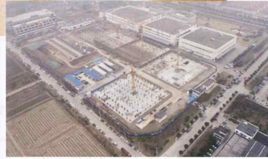
上海林内の工場増設
